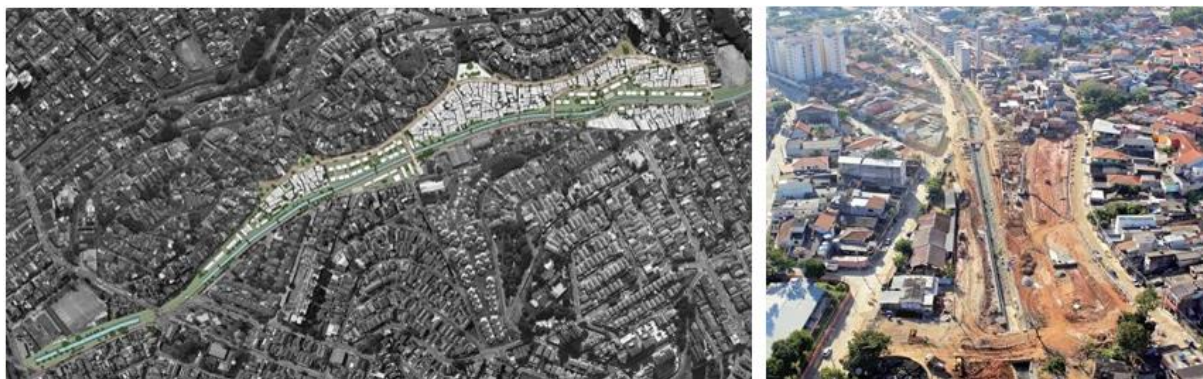
Figura 1 - Projeto urbanístico da Favela do Sapé obras nas margens do córrego
