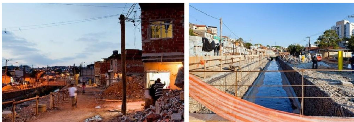
Figura 2 - Reurbanização da Favela do Sapé, São Paulo.
