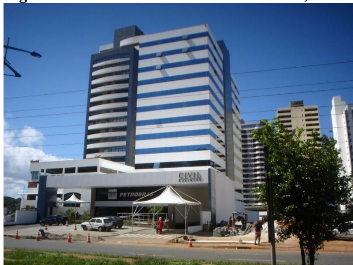
Figura 6: Prédio sede do COFIP – Salvador, Bahia.
